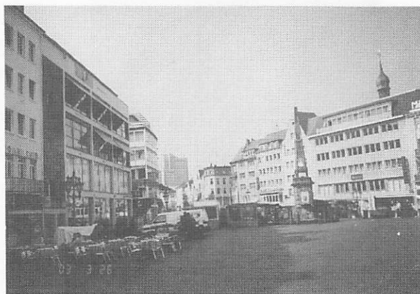
＜写真奥が現市役所＞
