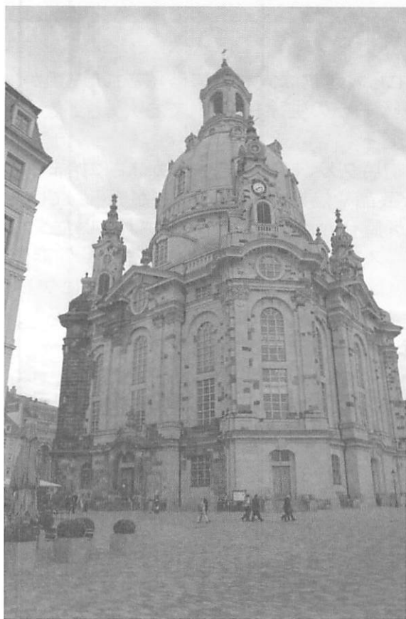
フラウエンキルヘ・ドレスデン
