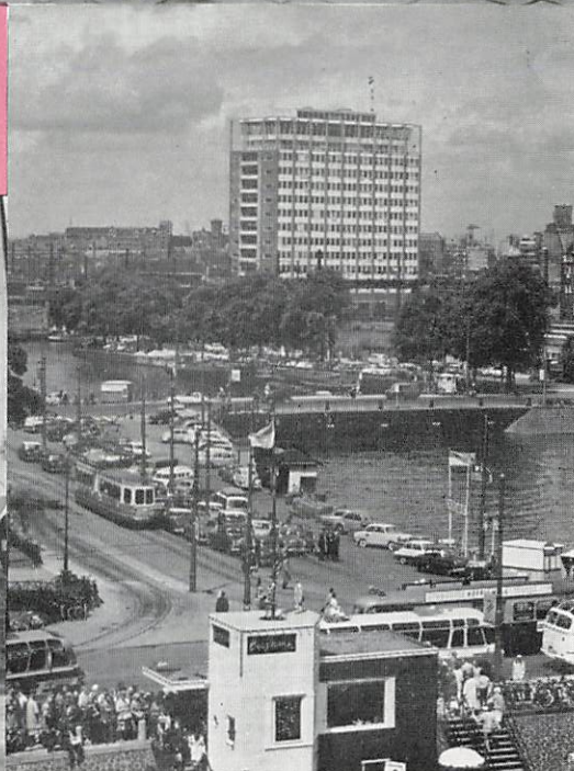
Popular canalboat landings and New Harbour Building テムズナルダムの名物、運河巡航船のりばとニュー・ハーバー・ビル
